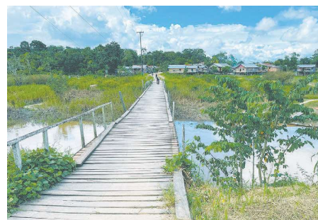
Ponte de acesso à comunidade Tikuna de Filadélfia
