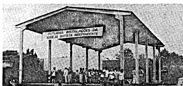
Obras do novo templo, em Cianorte.
