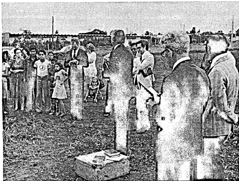
Lançamento da Pedra Fundamental da Creche em Ceilândia Sul
